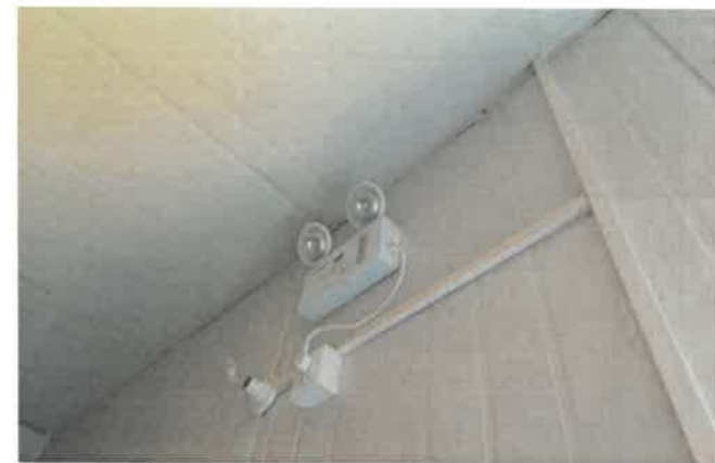
总配电房应急照明 参考图例1-6-4
