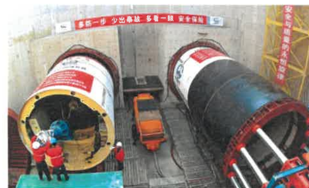
顶管施工工作井布置 参考图例3-3-19
