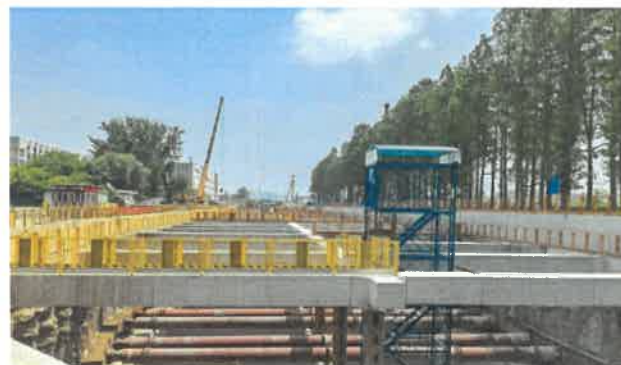
基坑临边防护 参考图例1-2-9
