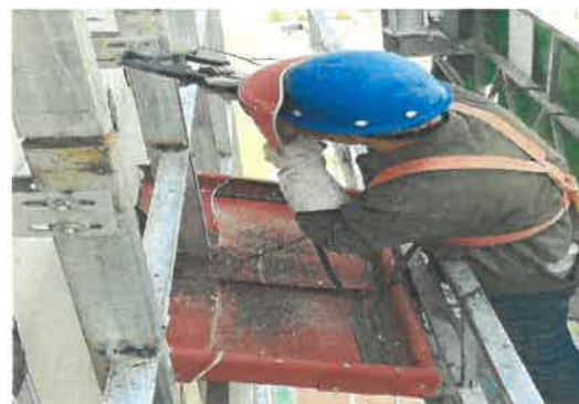
高空动火 参考图例2-1-3
