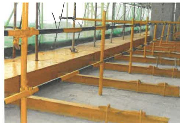
悬挑架底部硬封闭 参考图例1-3-8
