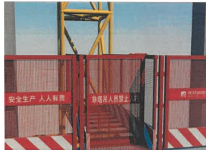
塔吊空中走道 参考图例1-5-5
