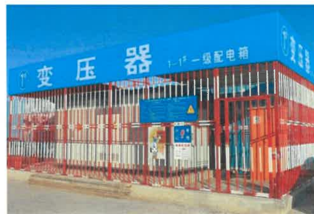
箱变防护 参考图例1-6-1
