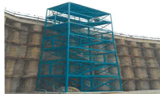
桩锚支护 参考图例1-2-3
