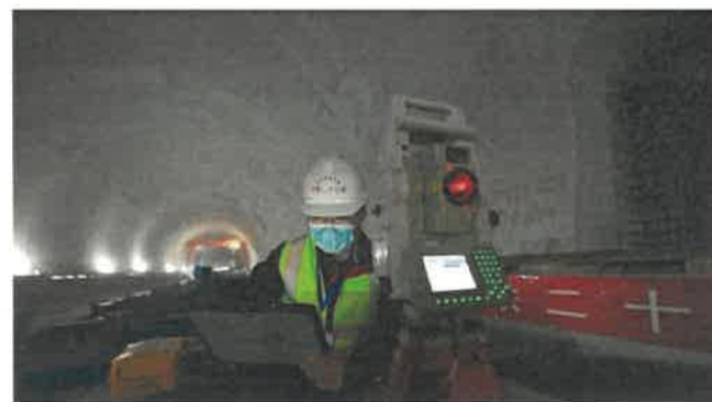
暗挖隧道监测 参考图例3-3-5
