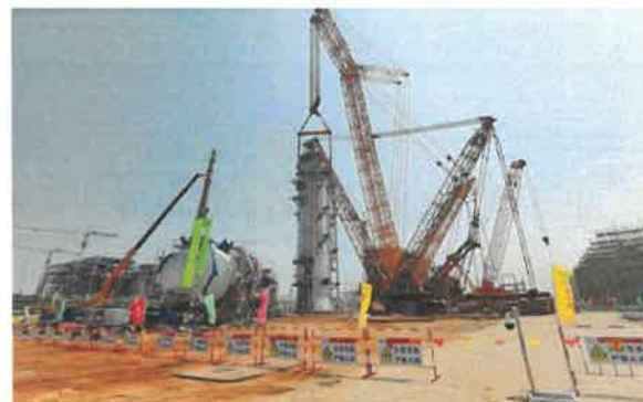
流动式起重机及吊装警戒 参考图例1-5-12
