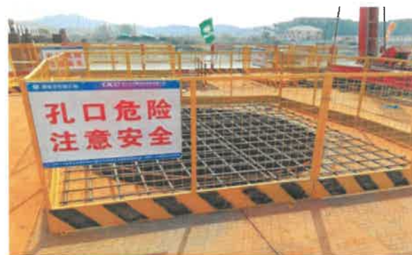
围堰安全防护 参考图例3-2-7
