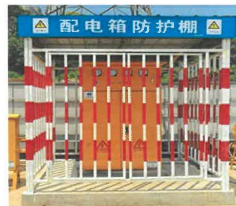
配电箱防护 参考图例1-6-6
