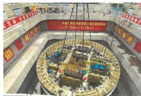
盾构机安装调试 参考图例3-3-14
