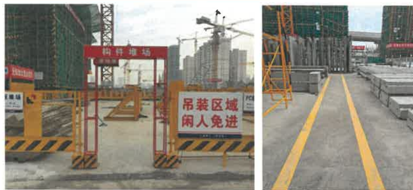
装配式材料堆放 参考图例2-4-1
