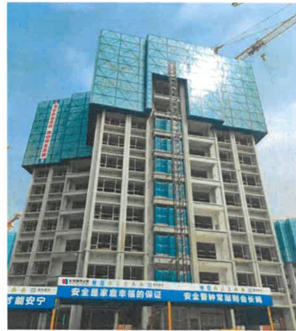
附着式脚手架整体效果图 参考图例1-3-11
