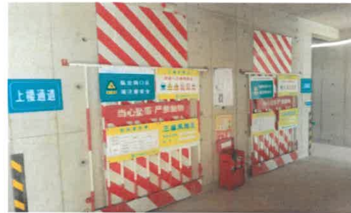
电梯井竖向防护及安全标识牌 参考图例1-4-5
