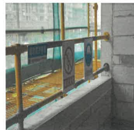
阳台、窗台临边防护栏杆 参考图例1-4-7
