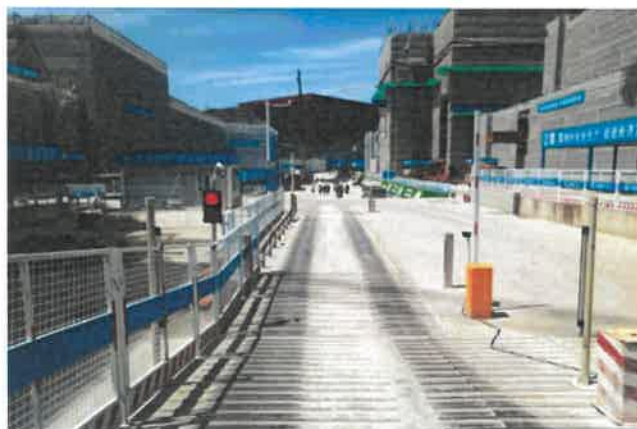
主出入口及地面 减速措施 参考图例1-1-19
