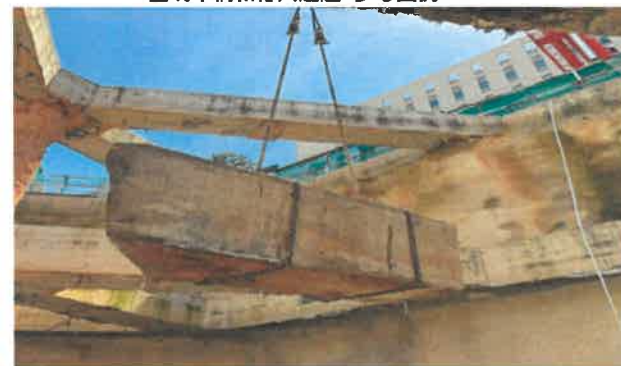
基坑支撑拆除 参考图例1-2-11
