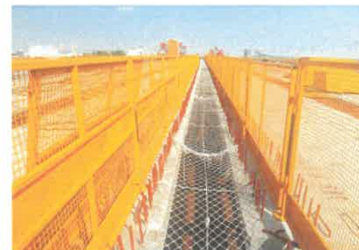
支架法施工安全防护 参考图例3-2-10
