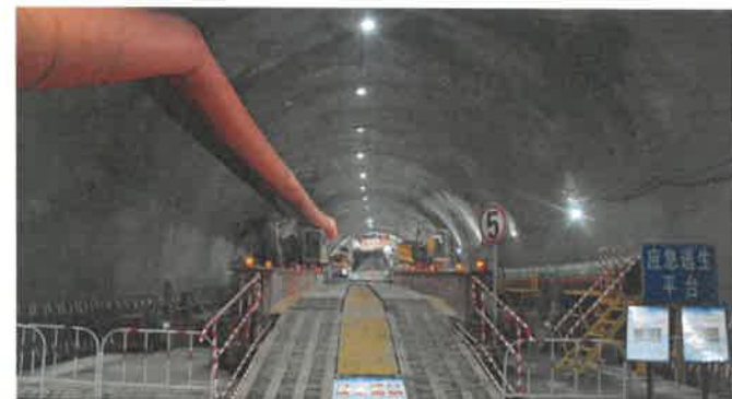
矿山法施工 参考图例3-3-6
