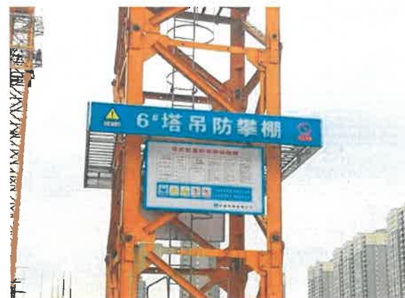
塔吊防攀爬 参考图例1-5-4
