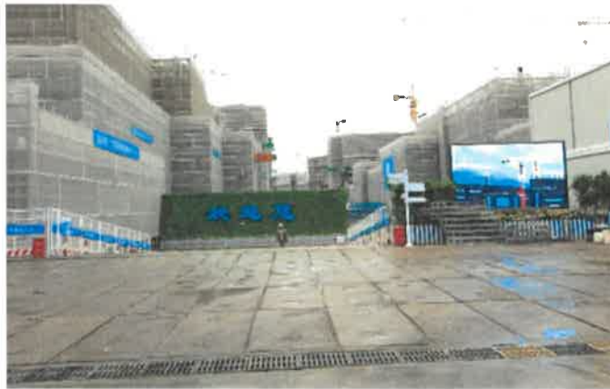
施工现场排水沟 参考图例1-1-24
