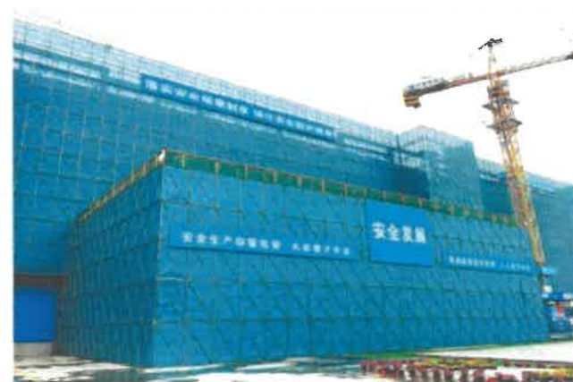
脚手架外立面防护 参考图例1-3-6
