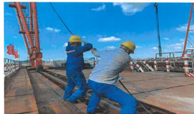
门式起重机防风措施 参考图例1-5-11
