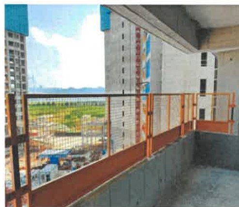
阳台、窗台临边防护栏杆 参考图例1-4-7
