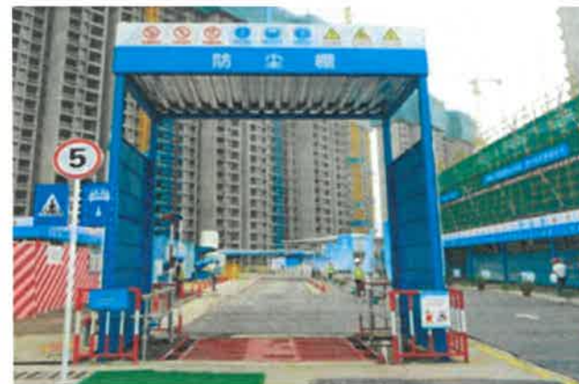
平面式冲洗台 参考图例1--1-7
