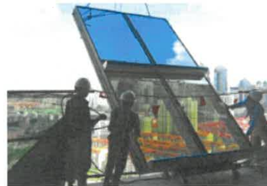
玻璃幕吊装 参考图例2-1-2
