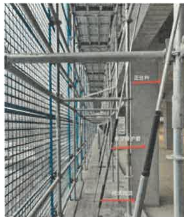
花篮拉杆式脚手架 参考图例1-3-10
