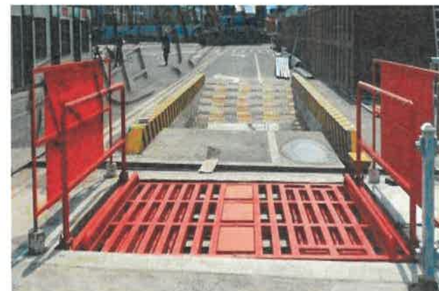
下沉式冲洗台 参考图例1-1-8
