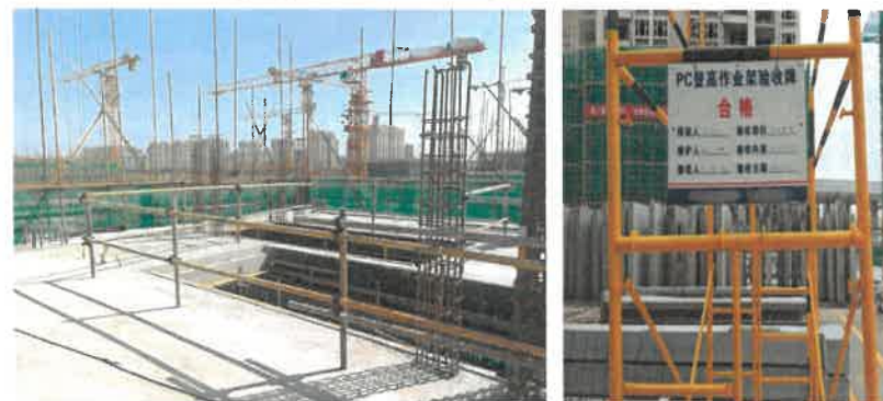
装配式结构洞口临边防护 参考图例2-4-3
