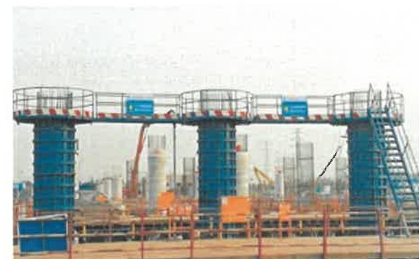
墩柱施工 参考图例3-2-8
