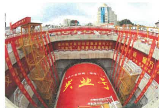
盾构机始发 参考图例3-3-15
