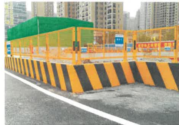
基坑临边防护 参考图例3-3-2
