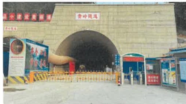
暗挖隧道洞口布置 参考图例3-3-4
