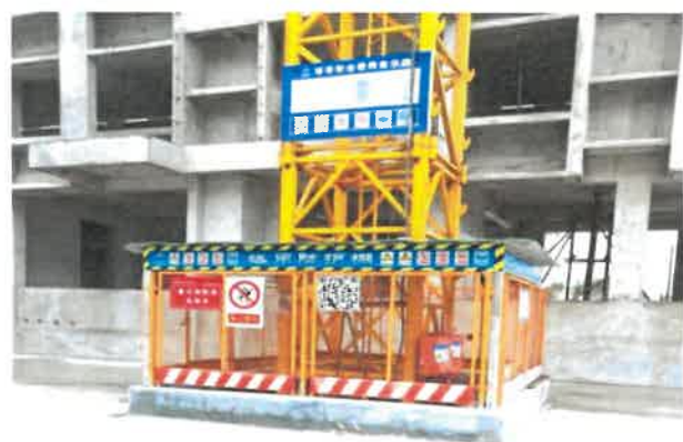
塔吊封闭层设置 参考图例1-5-3
