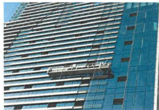
幕墙施工 参考图例2-1-1
