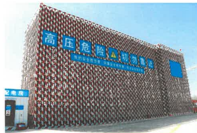
杆变防护 参考图例1-6-2
