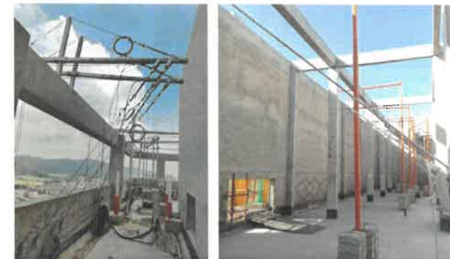
非标吊篮要求 参考图例1-3-17
