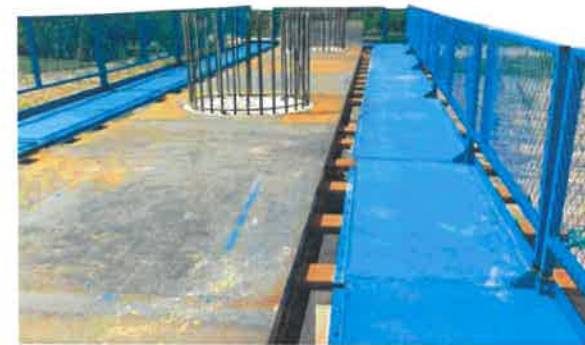
盖(系)梁安全爬梯和作业平台 参考图例3-2-9
