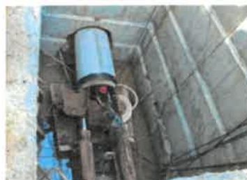
(e) 深基坑和地下管沟
